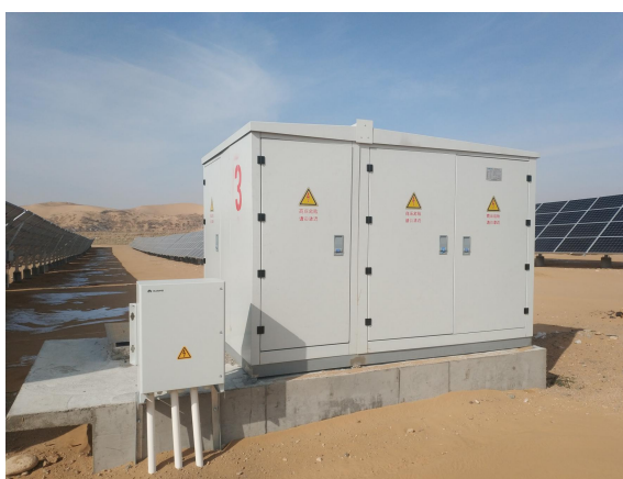
箱式升压变压器
