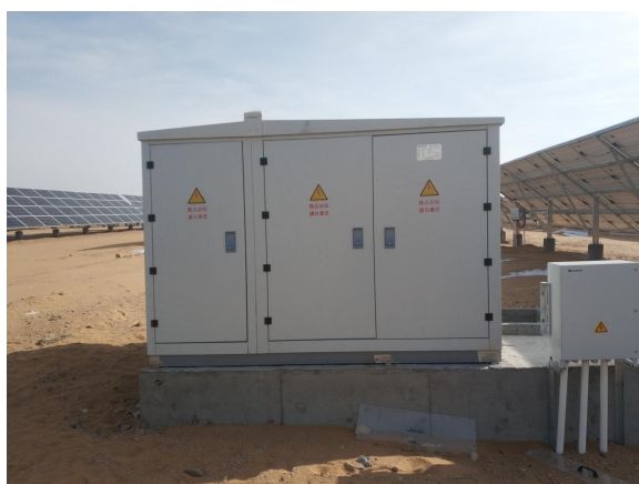
箱式升压变压器
